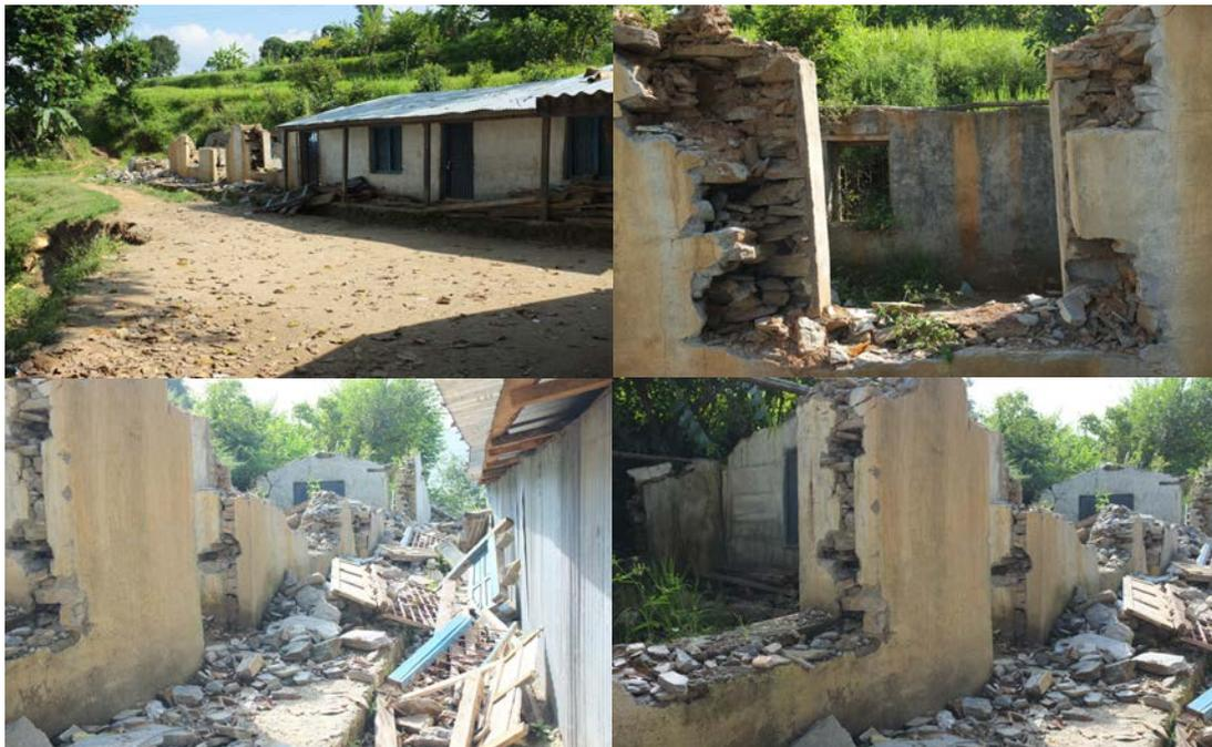
L'école, fortement endommagée lors du tremblement de terre, nécessitait d'importantes réparations mais pas nécessairement une reconstruction intégrale. Les architectes présents sur le terrain ont fortement déconseillé de détruire l'école car la reconstruction intégrale n'est pas nécessaire et serait très coûteuse alors que des réparations efficaces peuvent être faites.
